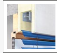
Einbau im Sturz
